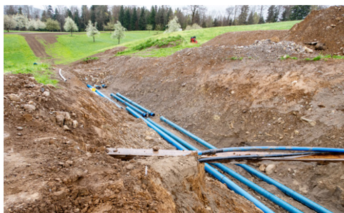
Neue Wasserleitungen Reservoir
