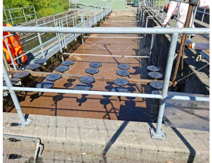
Belüftungsteller – System Absenken
