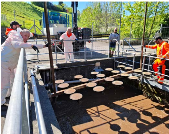
Belüftungsteller – System Anheben
