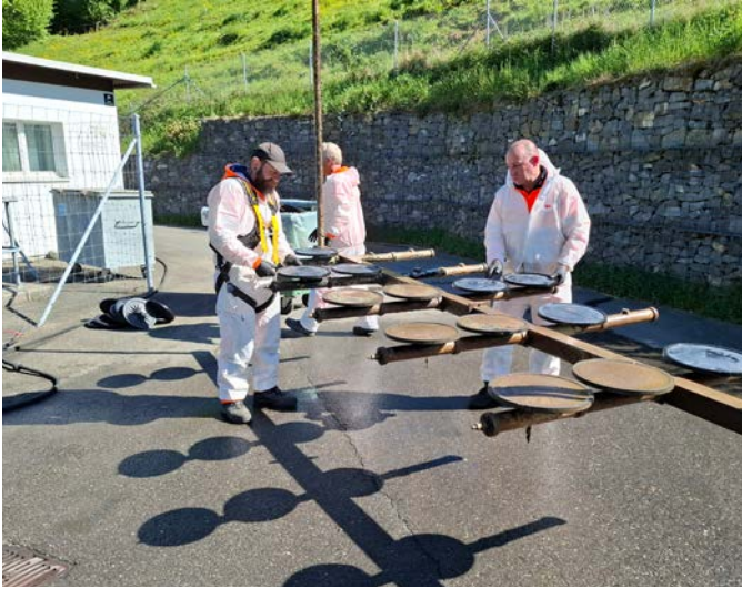
Ersatz der Belüftungsteller
