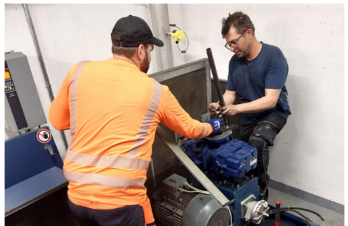
Revision der frequenzgesteuerten Luftzufuhr
