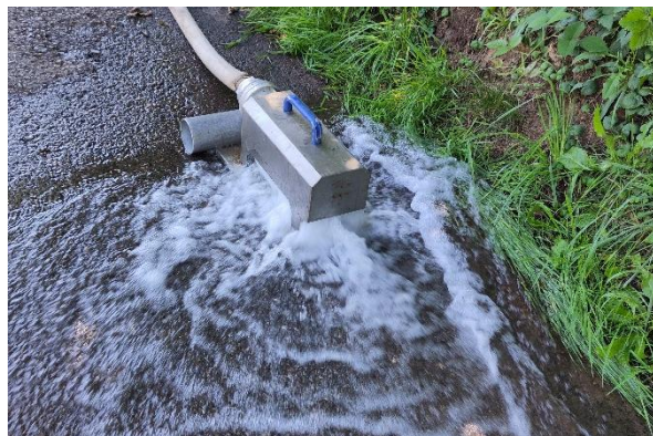
Abb. 21: Spülen neue Ableitung RES Blattweid
