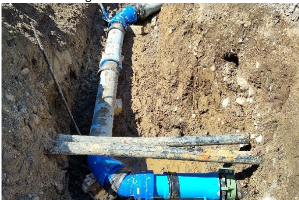
Abb. 20: Anschluss Reservoirableitung an best. Leitung
