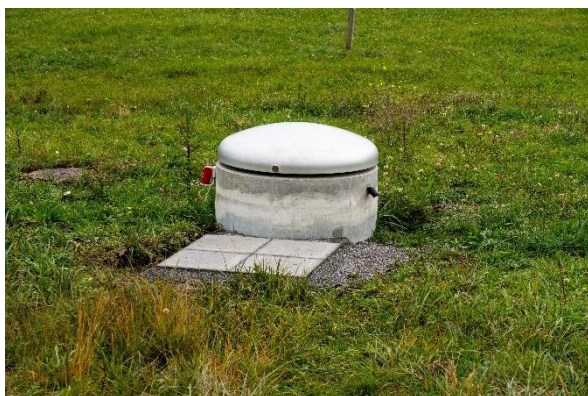
Abb. 10: sanierte BS Lüthärtigen aussen
