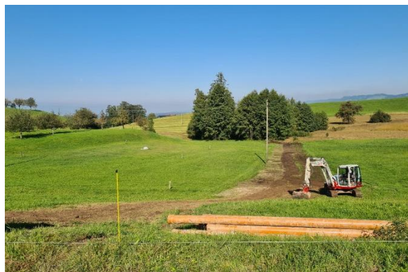
Abb. 23: Sanierung Strassenentwässerung Lüthärtigen
