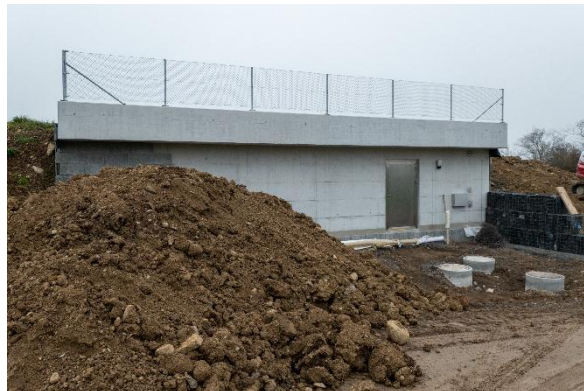
Abb. 17: RES Blattweid Umgebungsarbeiten
