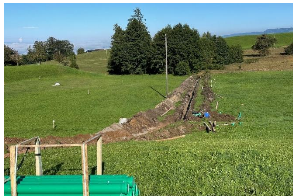
Abb. 22: Sanierung Strassenentwässerung Lüthärtigen
