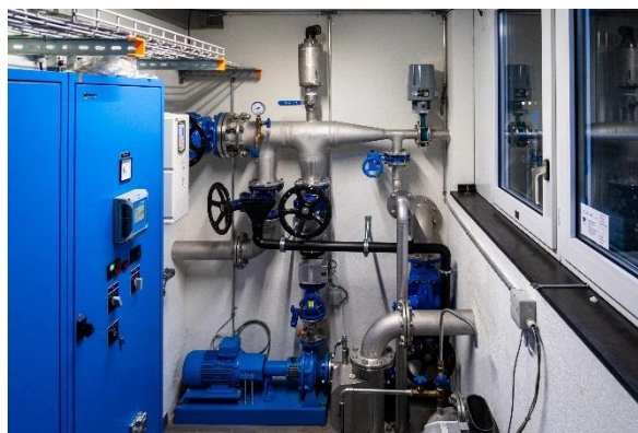
Abb. 11: sanierte BS Lüthärtigen innen
