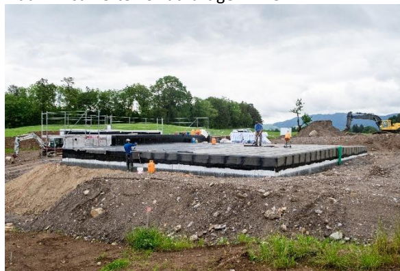
Abb. 13: RES Blattweid Abdichtung Dach
