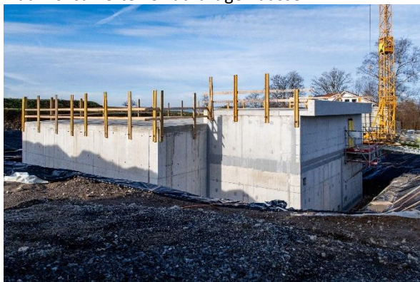
Abb. 12: RES Blattweid vor Hinterfüllung
